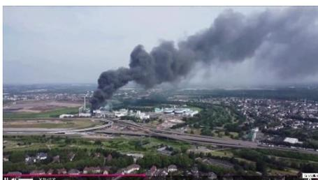
Die Explosion mit anschließendem Brand führte zum Totalschaden der Verbrennungsanlage. Die Explosion in einem Stahltank wurde durch eine chemisch reaktive Flüssigkeit mit einem Volumen von ca. 14 m<sup>3</sup> verursacht. Einzelne Trümmerteile flogen mehrere hundert Meter vom Ereignisort in die Umgebung.
